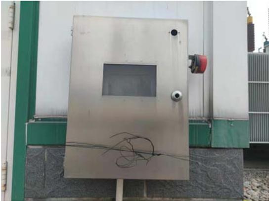
图6-4 SF<sub>6</sub>泄露报警仪
